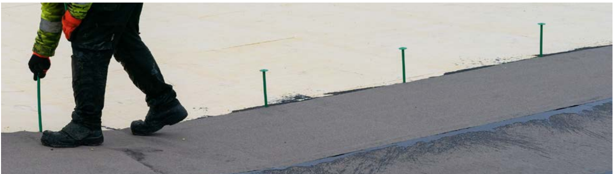
Eristeiden sekä vesikatemateriaalin kiinnitys mekaanisin kiinnikkein.
