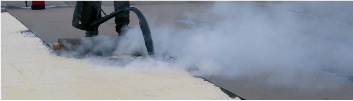
Liimausbitumi ei vaurioita eristeitä.
