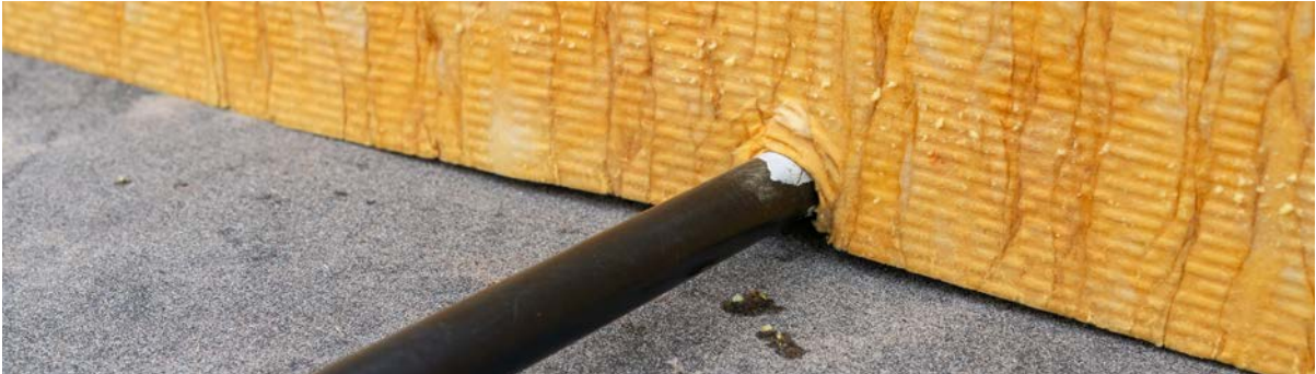
OL-LAM -eriste myötäilee helposti alustan epätasaisuuksia.
