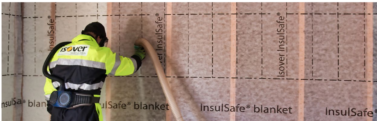
Huom! Kuva 3. Isover InsulSafe® Wall Blanket ei toimi rakenteen sisäpinnassa höyrynsulkuna, tai rakenteen ulkopinnassa tuulensuojana.
