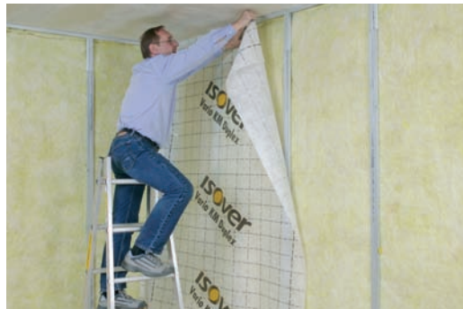
Sen jälkeen, kun metallista/puusta tehty runko on kiinnitetty lattiaan, seinään ja kattoon, metallista/puusta tehty runkoon asennetaan VARIO KM Duplex UV-höyrysulku.
