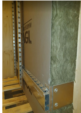
Kuva 10. SerpoVent U-Seinäkannakeosat A-B, sekä SerpoVent Hattuprofiilit OL-33 eristeeseen ja CLT-levyyn asennettuna
